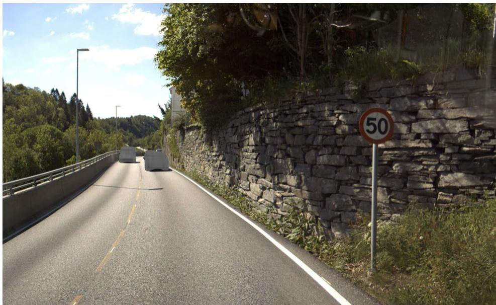
Figur 20 Forsterka rekkverk og vegmur på venstre side
