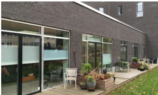
Figur 33 Blokkbuseiendommen i København viser korleis fyste etasjane kan nytte attraktive uteareal (VLFK)
