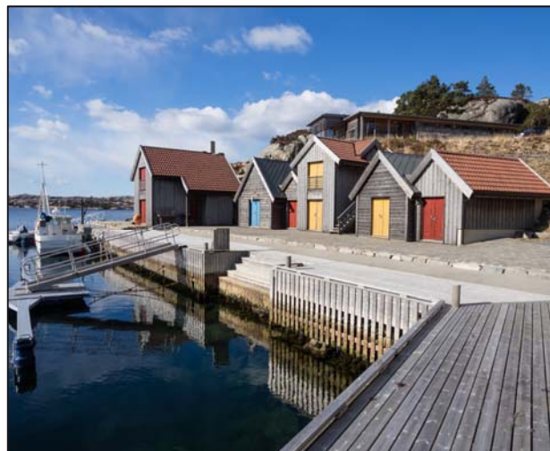
Figur 14 Naustområde og småbåtanlegg på Kråko. Foto Svein
