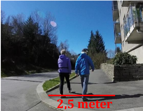
Figur 2-14: Syner eit fortausanlegg på Straume med breidde på 2,5 meter. 2 gåande som går ved sidan av kvarandre er nok til å redusere framkomst for syklande.
