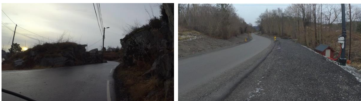
Figur 6-9: Til venstre Fv.5248 mellom Skiftesvik og Marikoven på Askøy. Til høgre inntrykk av framtidig fortau med breidde 3 meter mellom Erdal og Straumsnes som også er under utbygging på fv.5248. Bileta er henta frå sykkelkartleggingsrapporten på Askøy (Multiconsult 2020).
