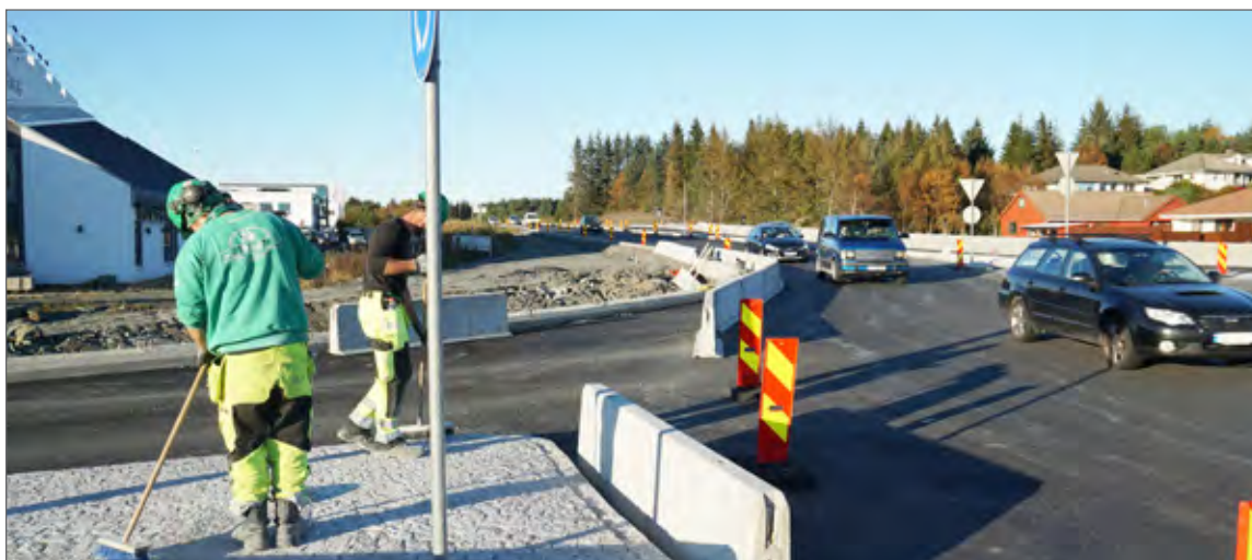
Utbedring av Fylkesvei 47 på Karmøy
