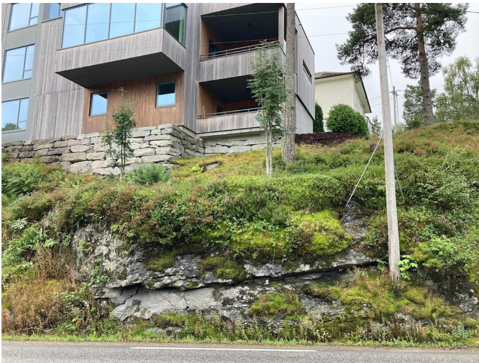
Figur 6-6: Bergblotning ved lokalitet A7 hvor skjæringstoppen til B1 planlegges 1 m fra overliggende bygning. Bildet er tatt mot sør. Kilde: COWI AS.
