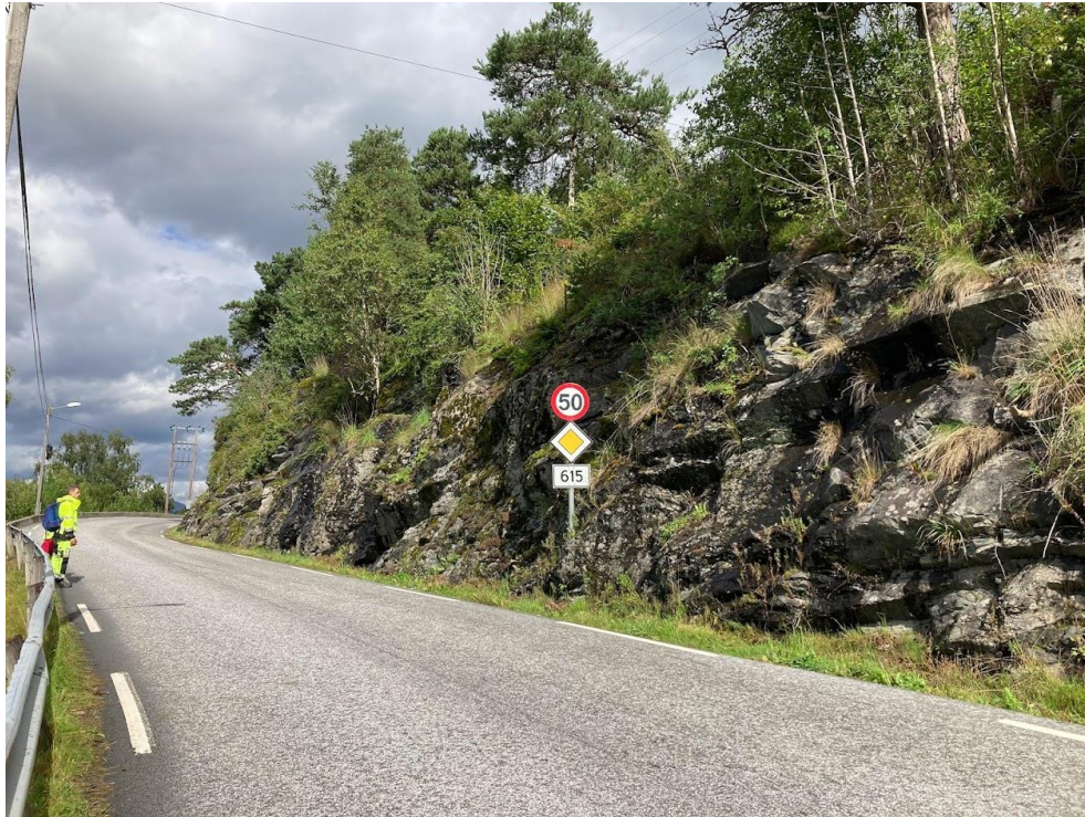
Figur 6-27: Eksisterende bergskjæring ved lokalitet A1. Bildet er tatt mot nord. Kilde: COWI AS.
