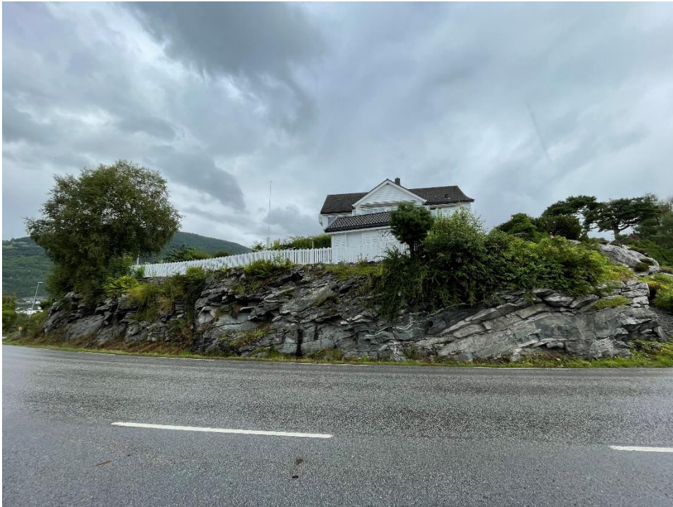
Figur 6-17: Eksisterende bergskjæring ved lokalitet A3 i vegsvingen. Bildet er tatt mot sørøst. Kilde: COWI AS.
