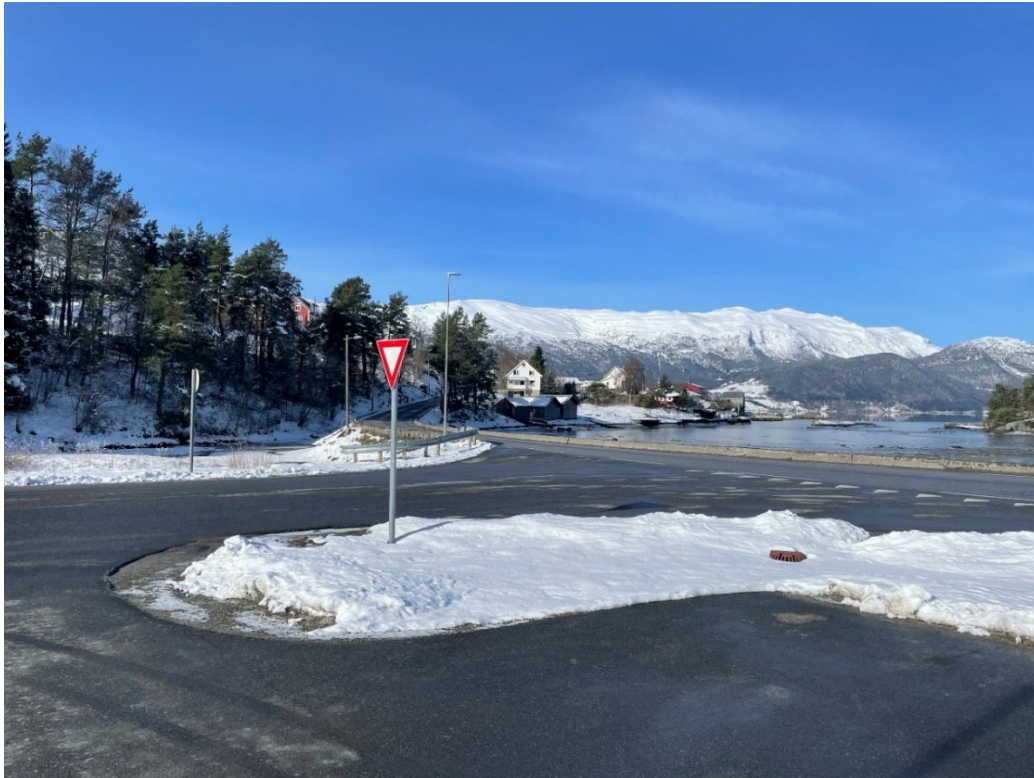
Figur 5.2 Krysset med kommunal veg i Selvågane Foto: Ingar Hals/Vestland fylkeskommune.
