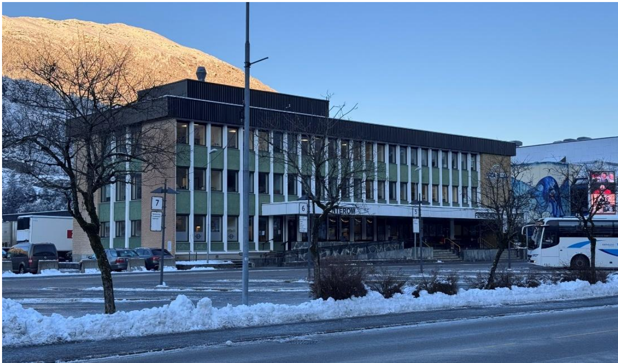
Figur 32 Bilete av administrasjonsbygget til Firda Billag
