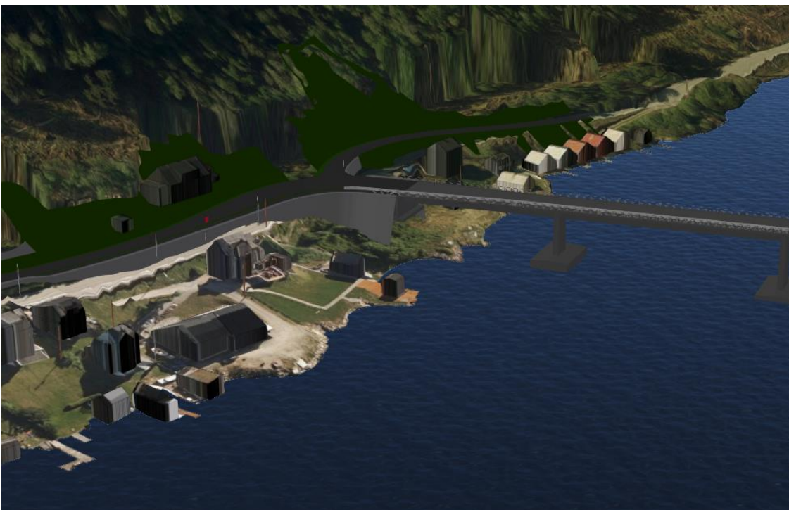
Figur 19 Ilandføring for 2C på sørsiden.
