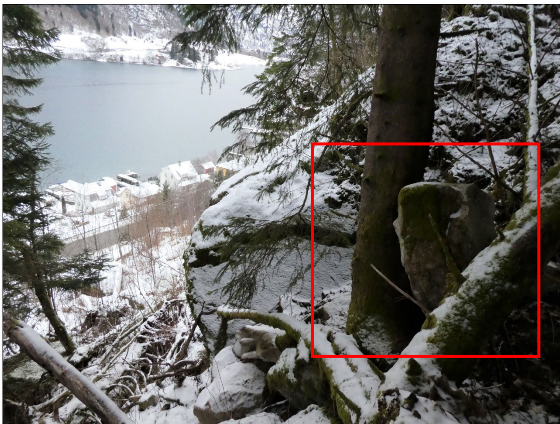
Figur 8: Nedfall frå berghammar over fv55 på sørsida av Esefjorden. Ei blokk har stoppa i eit grantre. Bilde er teke 28.01.2021.
