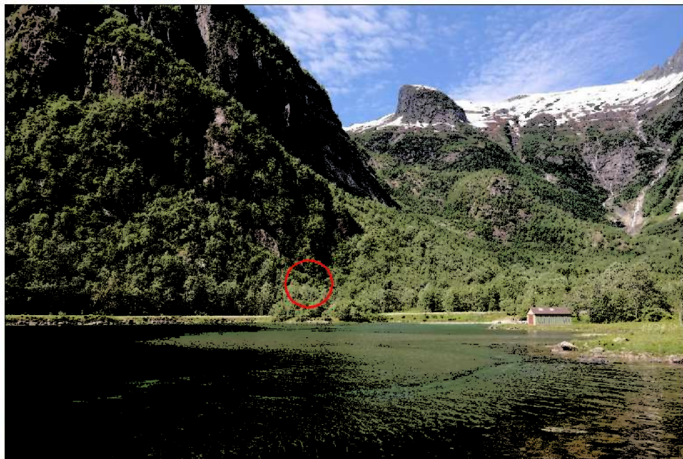
Figur 6: Bildet viser området i Esebotn og den bratte fjellveggen over det planlagte nordlige tunnelpåhugget (rød sirkel).
