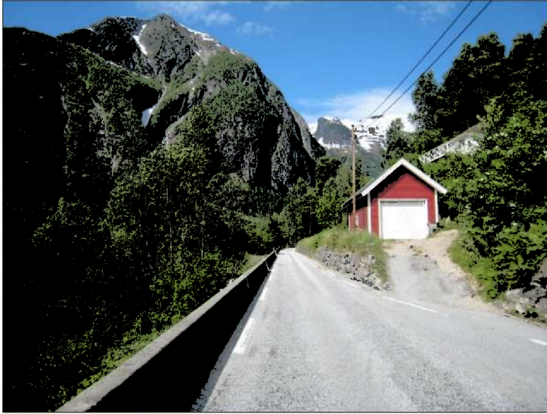
Figur 8: Dagens veg rundt Esefjorden er både smal og uoversiktlig. Vegen tilfredstiller ikke dagens krav til geometri. Foto: Nordplan AS
