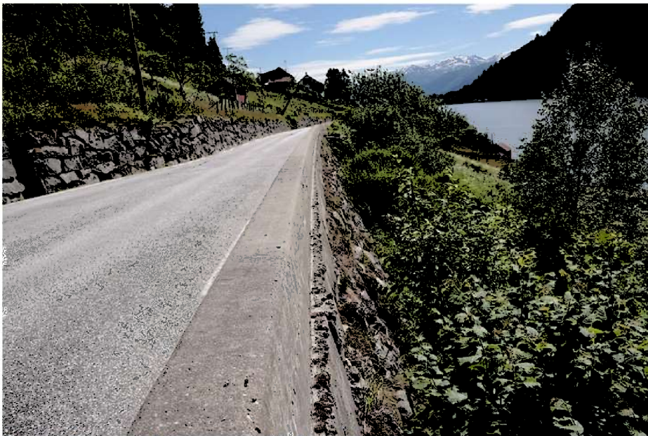
Figur 15: Eksempel på dagens vegprofil på nordsida av Esefjorden (foto:Nordplan juni2016)
