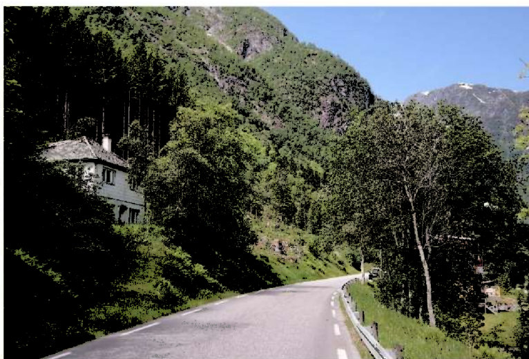
Figur 30: Bebyggelse tett på vegen og bratt terreng er en utfordring med tanke på breddeutvidelse og etablering av gang- og sykkelveg. (foto: Nordplan AS)
