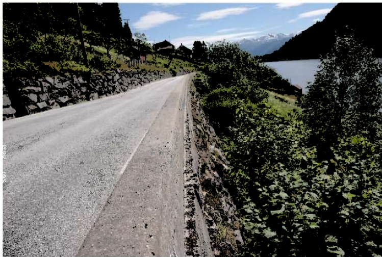
Figur 29: Det er strekingsvis bygd opp murer langs dagens veg på grunn av terrenget. En breddeutvidelse vil føre til nye og større murer på strekningen. Utbedring av dagens veg vil også legge beslag på areal. (foto: Nordplan AS)
