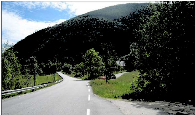
Figur 31: En utbedring av dagens veg gjennom Ese, samt etablering av gang- og sykkelveg vil kreve jordbruksareal, men vil ikke gi de samme terrengutslagene som i brattere områder langs Esefjorden. (Foto: Nordplan AS)
