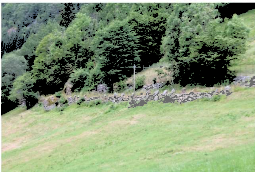
Figur 23. K 27 Gamlevegen. Oppbygd av mur og med stabbesteinar.
