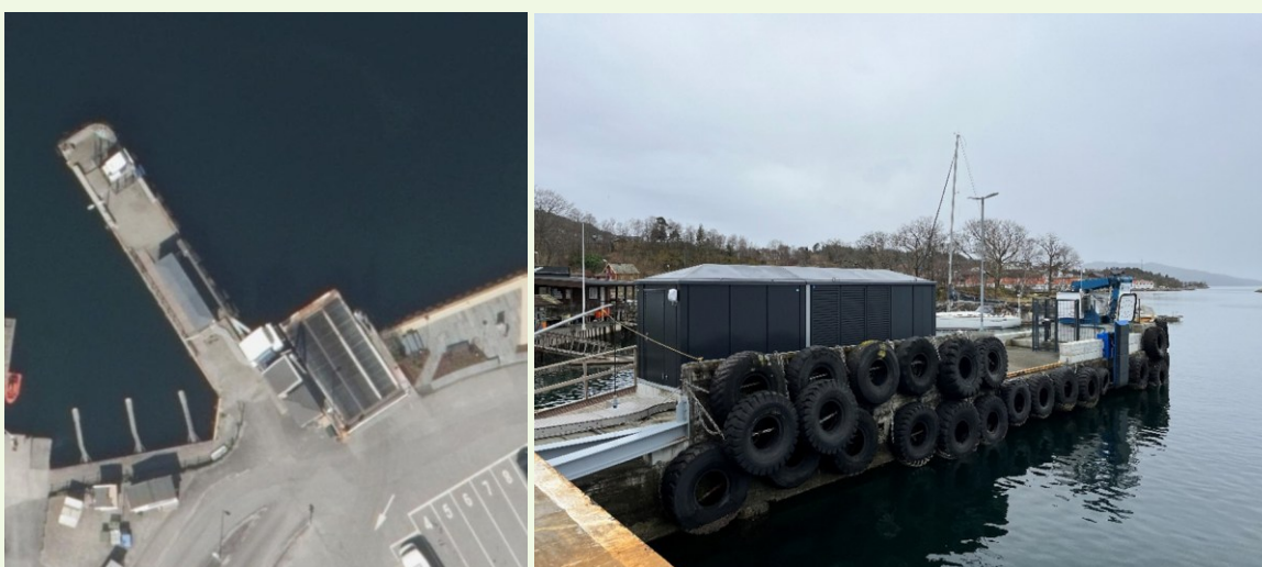
Figur 8 - Skånevik ferjekai – døme på ei dårleg tilpassa ferjekai der tilleggskai er sperra for tilkomst med fenderdekk som krev mykje vedlikehald (kjelde: Vestland fylkeskommune)
