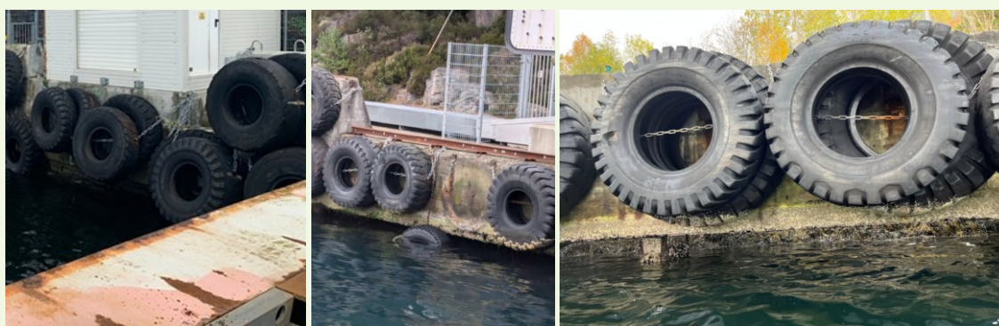
Figur 3 - Bilda viser fenderdekk som byr på store vedlikehaldskostnader (kjelde: Vestland fylkeskommune)
