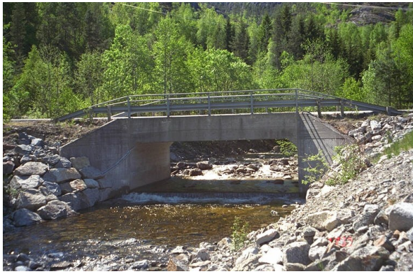
Figur 3-2: Kulvert/bru i fylling. Bilde til venstre er frå fv. 604 i Jostedalen (bruarkiv, Statens vegvesen). Bilde til høgre er frå fv. 556 Søreide (Multilux as).
