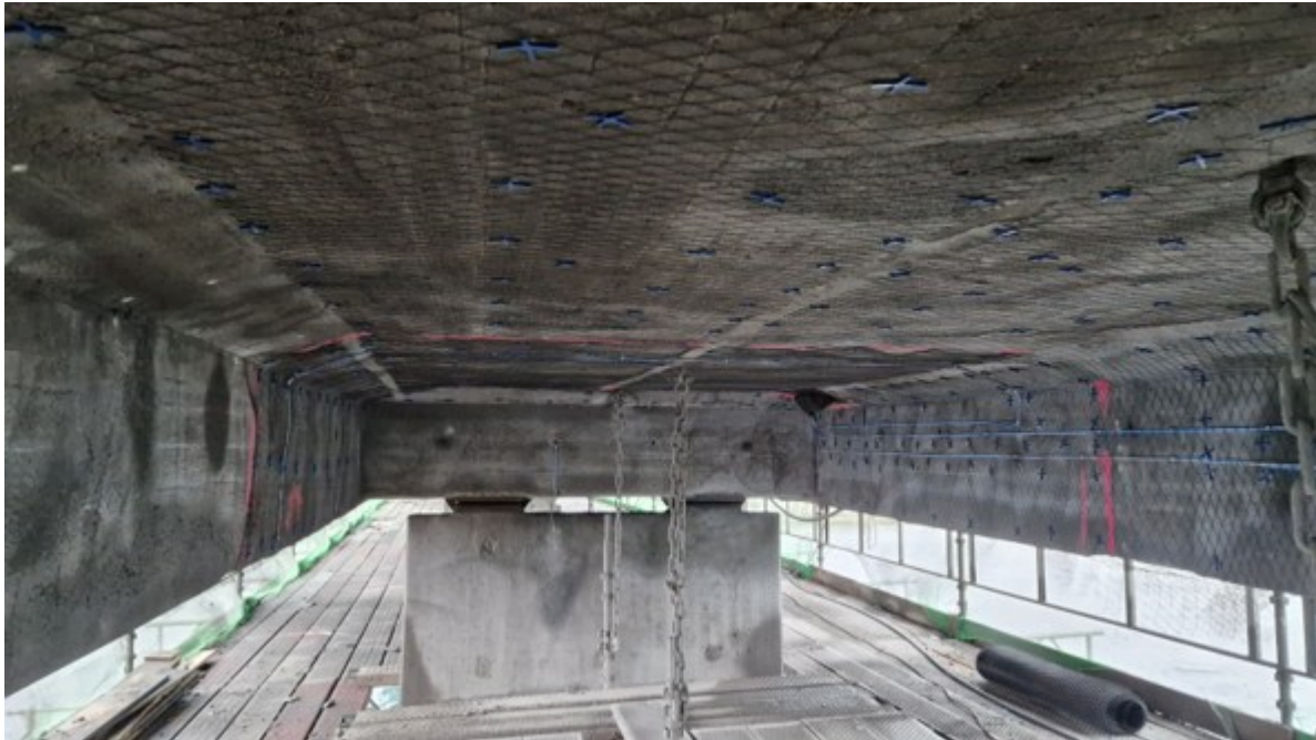
Figur 3-9: Montering av katodisk beskyttelse på Hamrøy bru (Vestland fylkeskommune).
