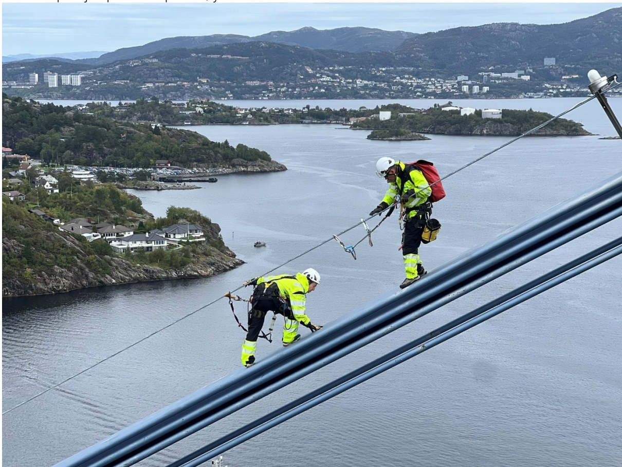
Figur 3-6:Hovudinspesksjon av kablar på Askøybrua (Vestland fylkeskommune).
