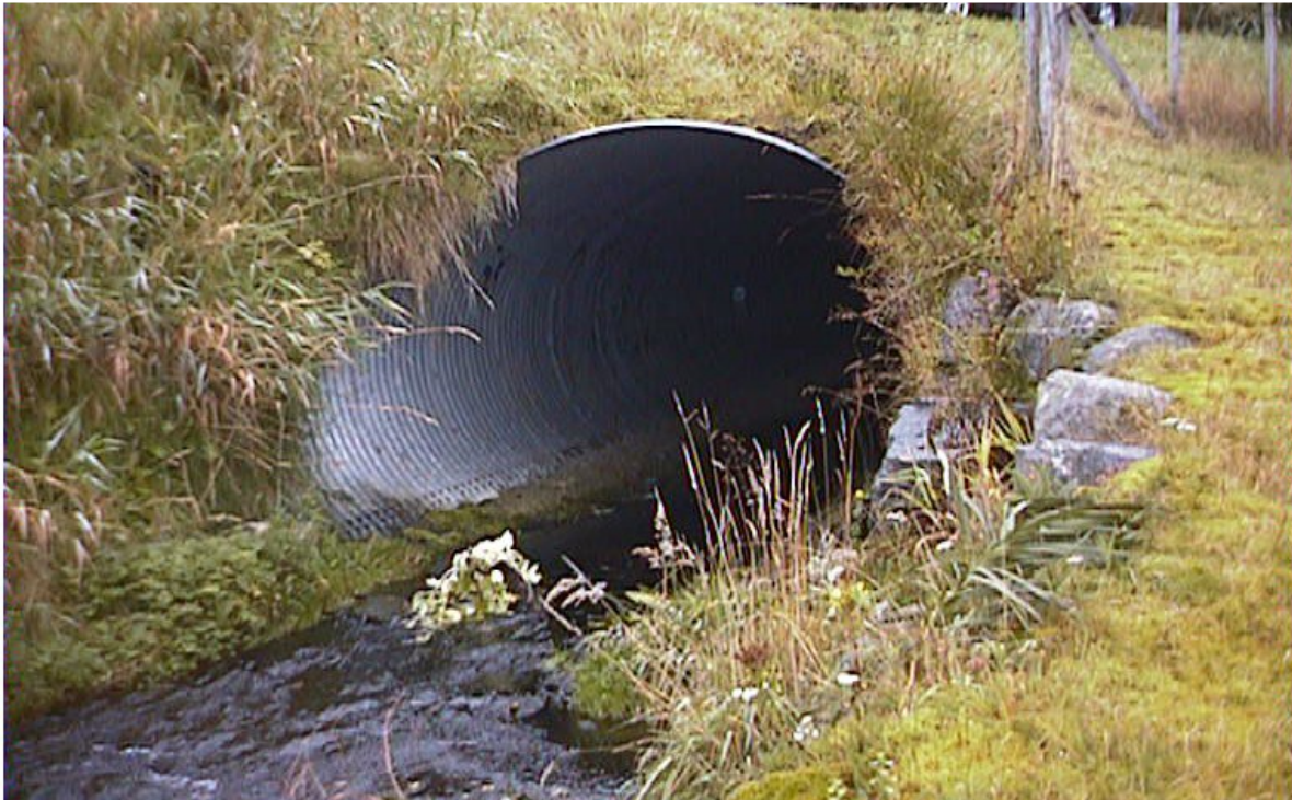
Figur 3-3: Korrugert rør i fylling: Fv. 620 Leikanger i Stad kommune. (Bruarkiv Statens vegvesen)
