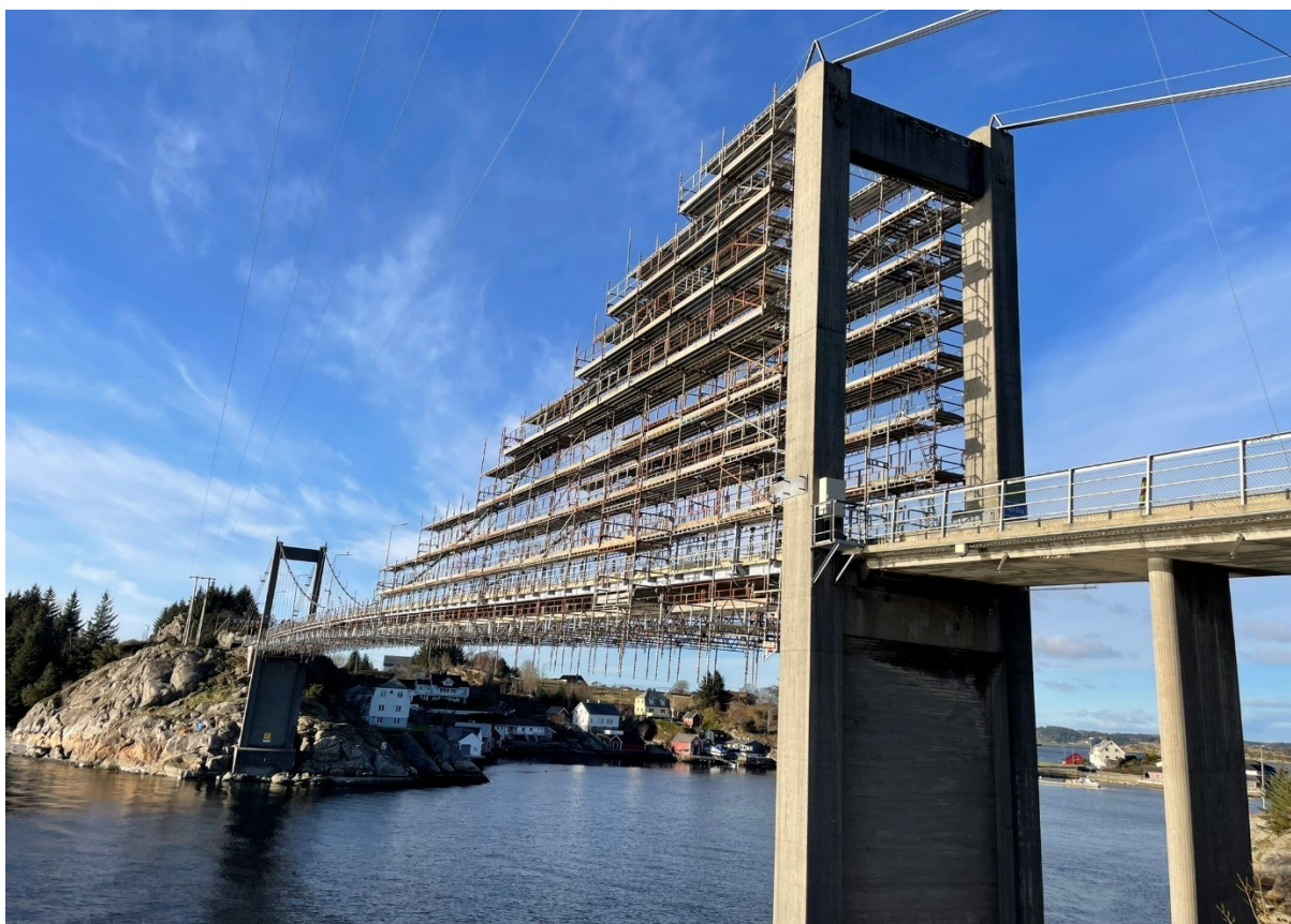
Figur 3-7: Herdla bru, overflatebehandling av hovudkabel og hengestenger (Vestland fylkeskommune).
