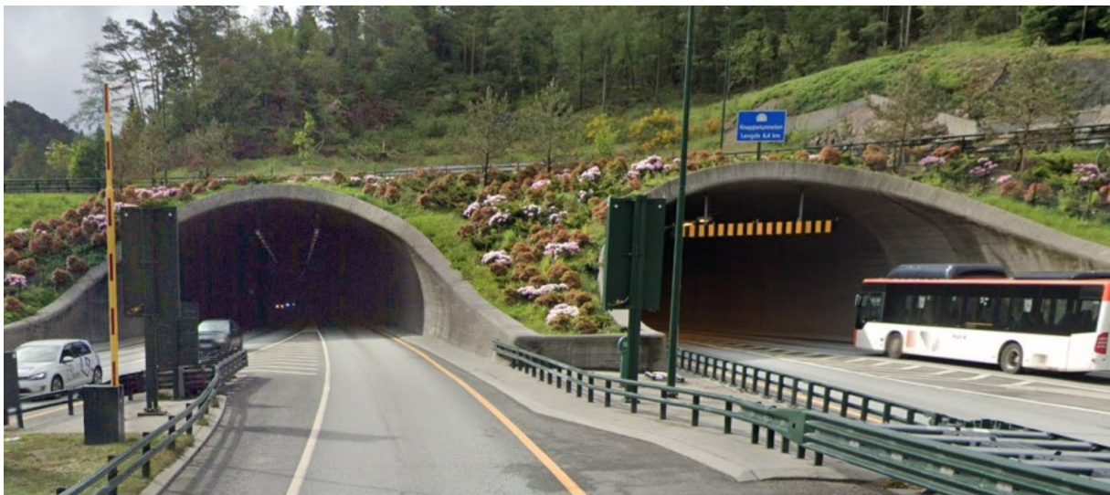
Figur 4-1: Tunnelportalar med bilveg over, fv. 557 Knappetunnelen (Google Street View)
