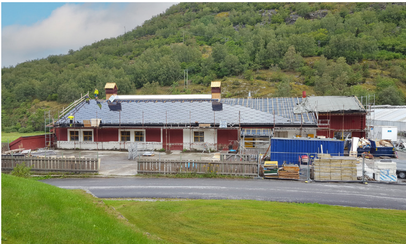
Solcellepanel på Sogn jord- og hagebruksskule. Foto: Vestland fylkeskommune
