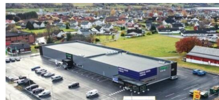
Energihub i Nordfjordeid
