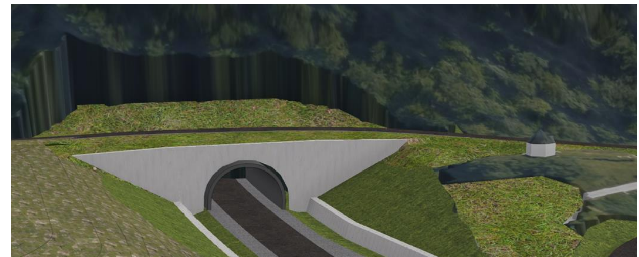
Figur 33- Natursteinmurar ved tunnelportal i Eikedalen. ( VLFK)
