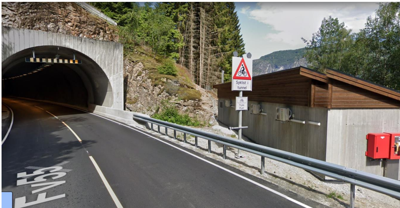
Figur 8-4: Blinkande varselkilt gjer bilistar oppmerksame på at det befinn seg syklistar i tunnelen. Utklipp frå Google Streetview. Fv.55 i Luster kommune.
