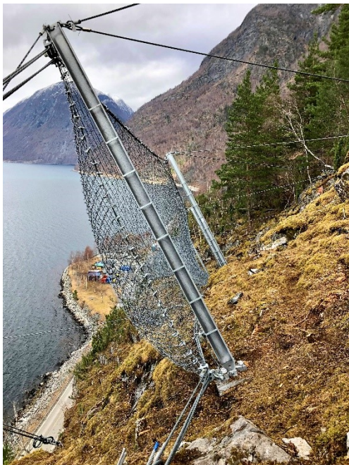
Bilde 21: Rassikring ved Årøyne; Foto: VLFK
